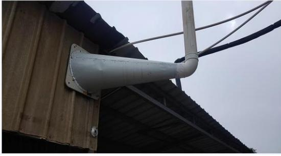
图 4-5 危废暂存间废气收集管道
