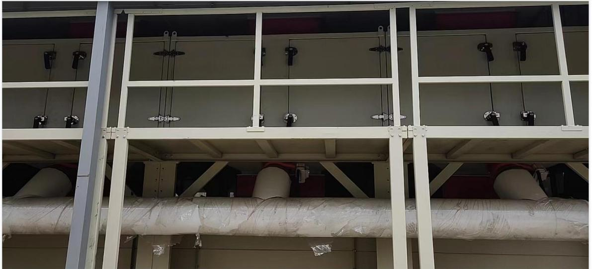
图4-3项目配套二级活性炭吸附/脱附+催化燃烧装置
